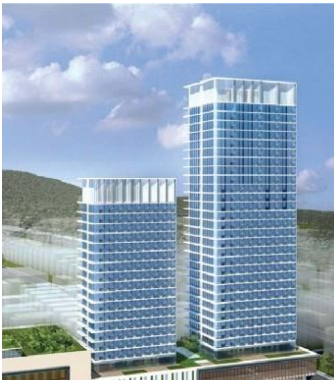
Công trình: Khu căn hộ khách sạn BMC Quy Nhơn
